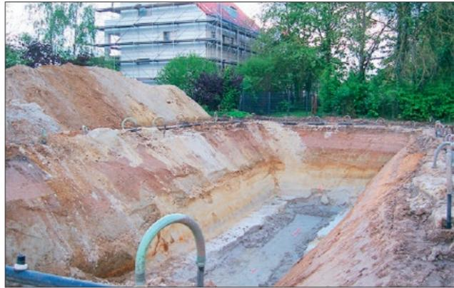
Erhebliche Ausmaße und 4,50 m tief ist die Grube zur unterirdischen Lagerung der 100 Kubikmeter Löschwasser.
